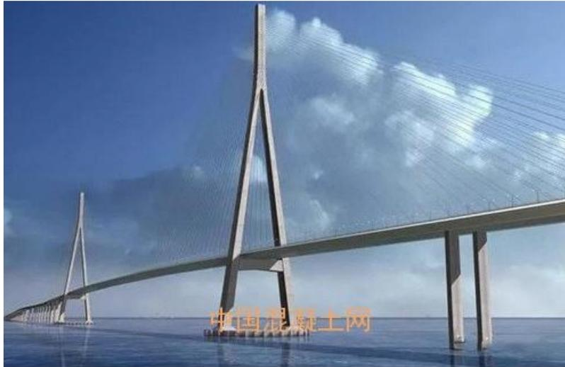
该桥面板的设计理念、施工工艺、生产线设备均是国内外首创，它所采用的粗骨料活性粉末混凝土是新一代水泥基材料。与普通混凝土不同的是，这种混凝土加入了活性粉末、钢纤维等材料，具有超高强度、高抗压、高抗拉等特征。据技术负责人刘立海介绍，其抗压强度超过 150 兆帕，芜湖长江二桥等主塔混凝土强度为 50 兆帕，这种混凝土是普通混凝土的 3~5 倍，可以和铸铁媲美，承担相同车辆和人群重量时可以大大减少混凝土用量，而且耐久性远好于普通混凝土，微细裂缝可以自愈合。
