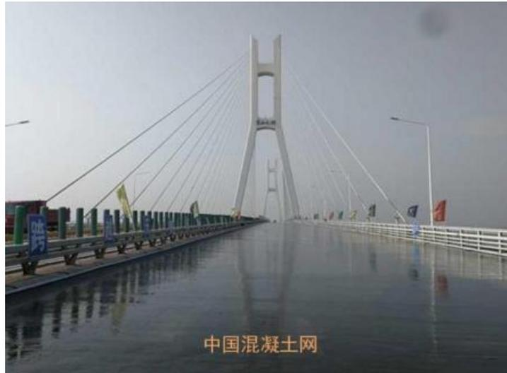
用 100 年才磨损 2 毫米的混凝土，在武汉军山长江大桥维修改造中大显身手。11 月 29 日，由中铁大桥科学研究院自主研发的这种超高性能混凝土在军山长江大桥铺装完成，它将为大桥穿上“防护衣”，确保桥面“长寿”。
