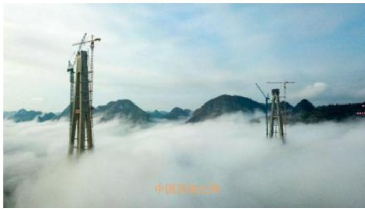
平塘特大桥为平罗高速的控制性工程，该桥位于贵州省余庆至安龙高速公路平塘至罗甸段，横跨槽渡河峡谷，桥梁宽30.2米，长2135米，设计时速80公里。该桥预计总投资15亿元，2016年4月开工建设，计划于2019年建成。
