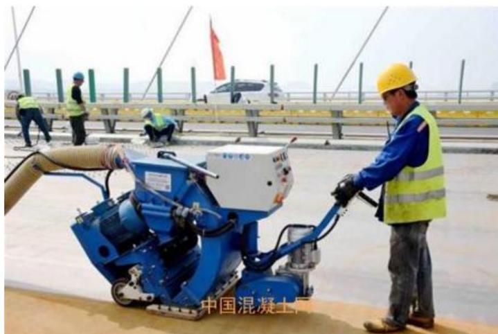
记者在现场看到，军山长江大桥由南往北的一段 900 多米桥面，在阳光映射下如同镜面闪闪发光。项目总工程师陈露一介绍，高性能混凝土已经完成铺装，如镜面光滑的表面是环氧防水粘结层，上面还将铺设一层沥青。
