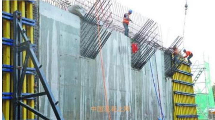
“平整光滑，色泽均匀，简直就是一件工艺品！”抚摸着刚刚脱模用清水混凝土浇筑的太湖隧道过渡段侧墙，苏锡常南部高速公路项目总监万秀贵难掩喜悦之情。近日，太湖隧道马山段工程敞开段首节清水混凝土侧墙拆模，长 15 米、高 5.2 米的侧墙展现真容(上图)。据悉，仅该段侧墙就累计使用混凝土 104 立方米，浇筑历时 6 小时，接下来还有面积近 1 万平方米的侧墙和顶板将完成清水混凝土浇筑脱模，以堪比工艺品的装饰效果展现“太湖隧道美”。
