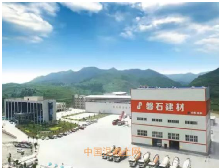
图为毕节双山开发区磐石建材有限公司
