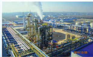
20万吨EO及30万吨EOD精细化工新材料项目
