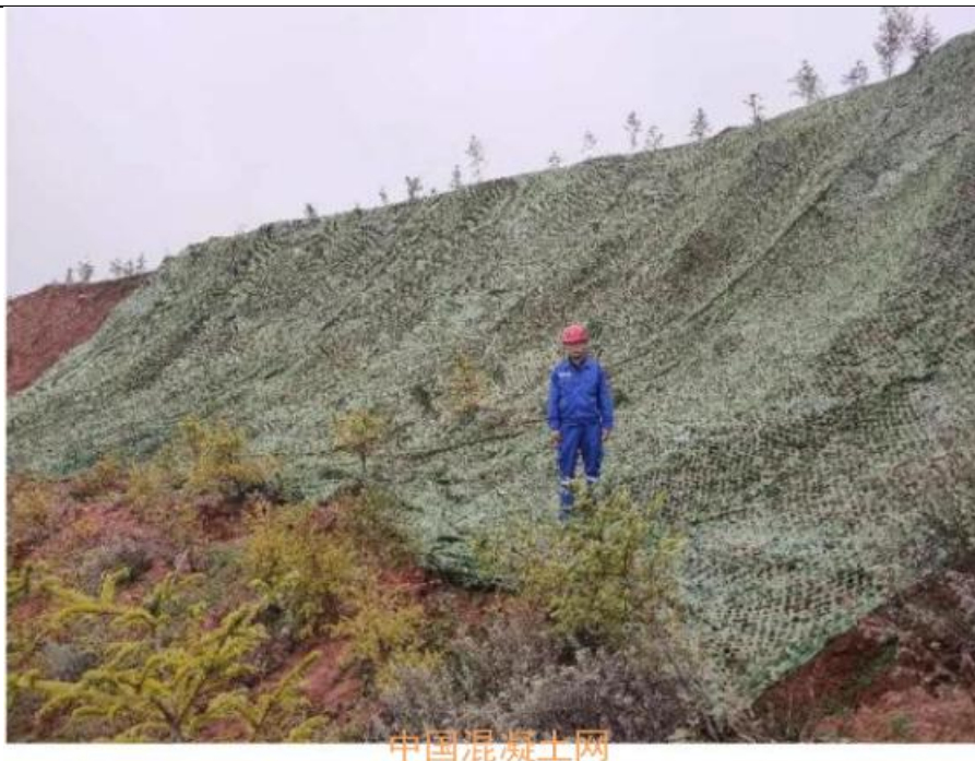
图2 对未开展矿山地质环境恢复区域遮盖的迷彩网
