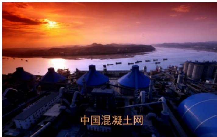
华润水泥封开基地 生产线及码头
