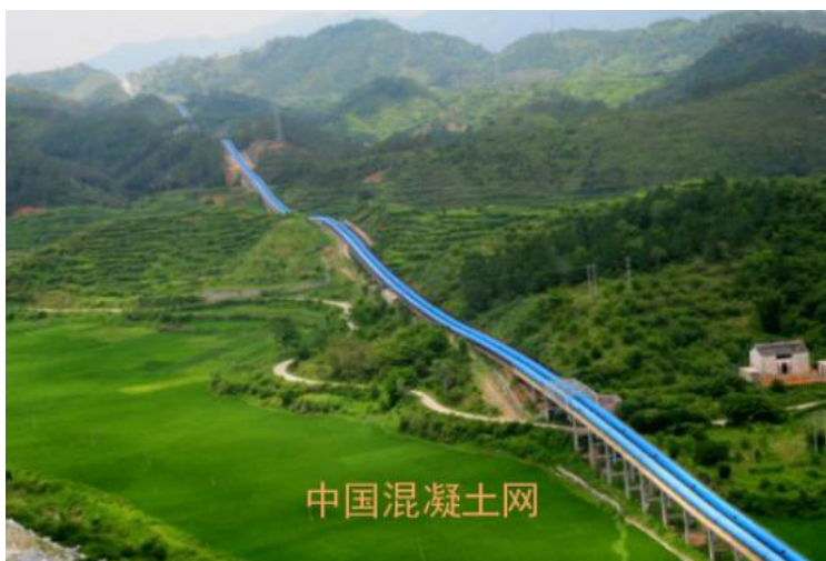
华润水泥封开基地 皮带廊
