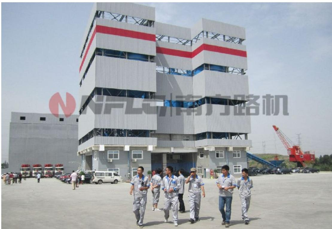
场内不见飞扬的尘土，不闻轰鸣的噪音，更没有滴漏邈邈的水泥罐车。“搅拌站主楼外的钢结构都已经搭建好，马上就要进行外围的最后施工，从搅拌楼到料仓全部封闭。夏天气温高，还会自动喷淋，保证区域内不见尘土。”公司总经理刘玉萍介绍，站内还引进了先进的分离和污水处理设备，将废弃的混凝土进行分离、过滤后用于混凝土再生产，真正实现废水废渣零排放。“这样既解决了污染问题，又提高了材料利用率，是生态效益和经济效益的双赢。这也是常州首家全封闭绿色环保混凝土搅拌站。”据悉，整个项目投入已近亿元，是建造一个传统型搅拌站投入成本的 2 倍。
