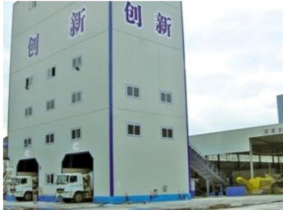
图为混凝土搅拌车从封闭式搅拌站内装载运输场景
