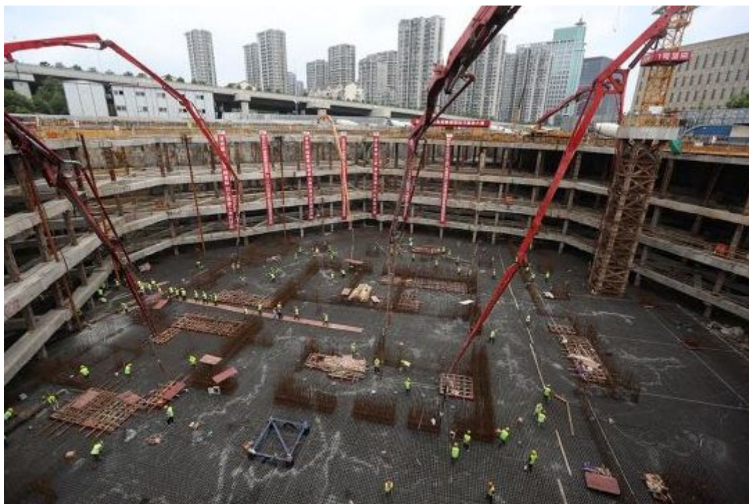
一次性浇筑如此规模底板混凝土，实属罕见
