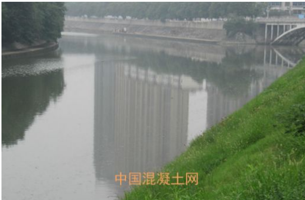
生态混凝土做成的护坡
