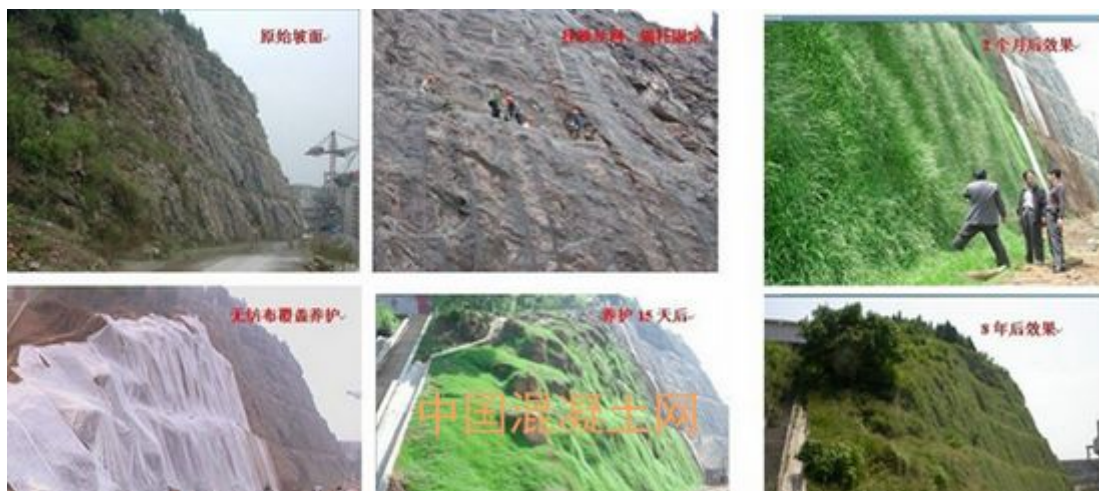
植被混凝土绿化添加剂使用效果
