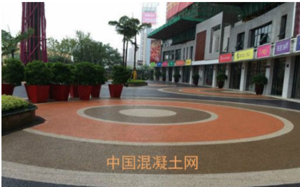
彩色混凝土做成的地坪
