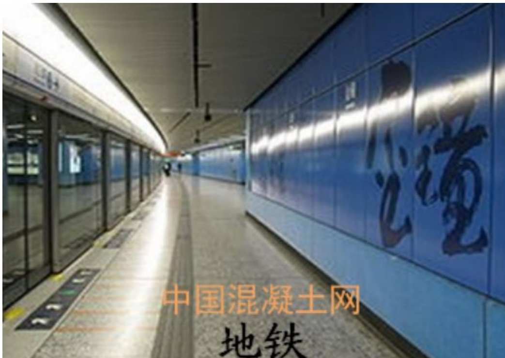
吸音混凝土在地铁中得到应用
