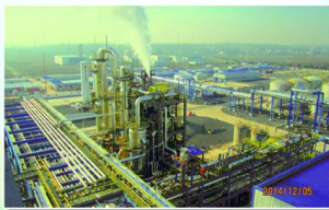
20万吨E0及30万吨E0D精细化工新材料项目
