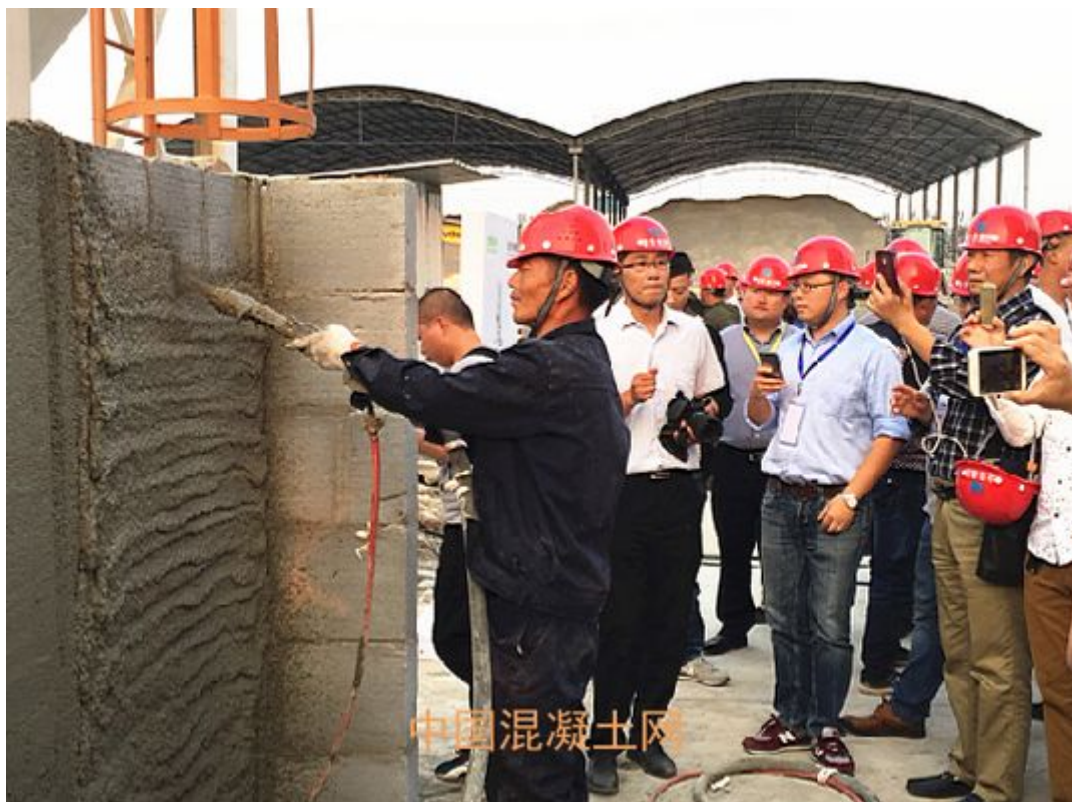
客户观看现场施工
