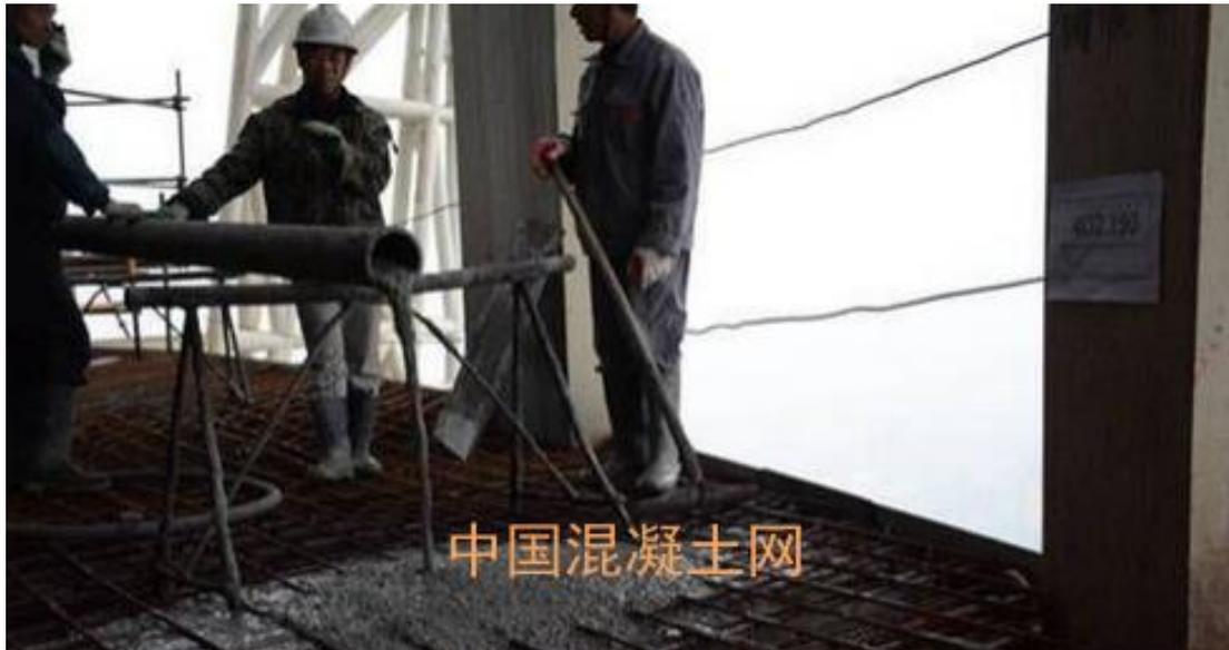
“我们再一次刷新了世界纪录！”欢呼声从江城之巅武汉中心大厦 400 米天际线传出。11 月 13 日，中建西部建设子企业——中建商品混凝土有限公司（以下简称“中建商砼”）成功将 LC40 轻集料混凝土泵送至华中第一高楼——武汉中心大厦第 88 层楼顶，垂直泵送高度达到 402.150 米，刷新国内外轻集料混凝土泵送高度纪录。标志着中建商砼在轻集料混凝土的科技研发和混凝土超高层泵送技术水平跻身世界之最，达到国际顶尖水平。
