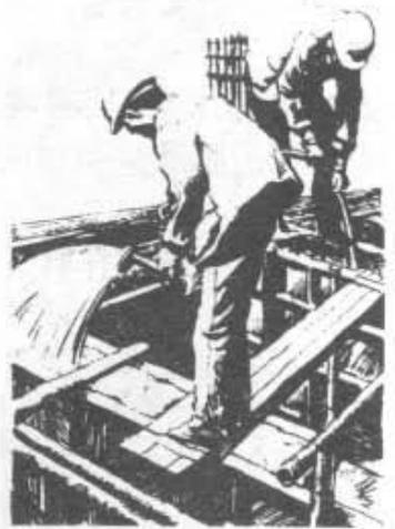
在建筑工地上，对浇筑成型的混凝土覆盖浇水养护是一件很平常的事。现对其覆盖浇水养护的机理及作用进行分析，以便走出对其认识的几个误区。
