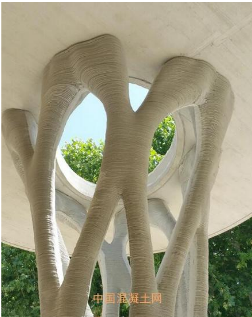
3D 打印混凝土承重柱
