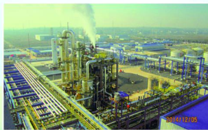
20万吨E0及30万吨EOD精细化工新材料项目
