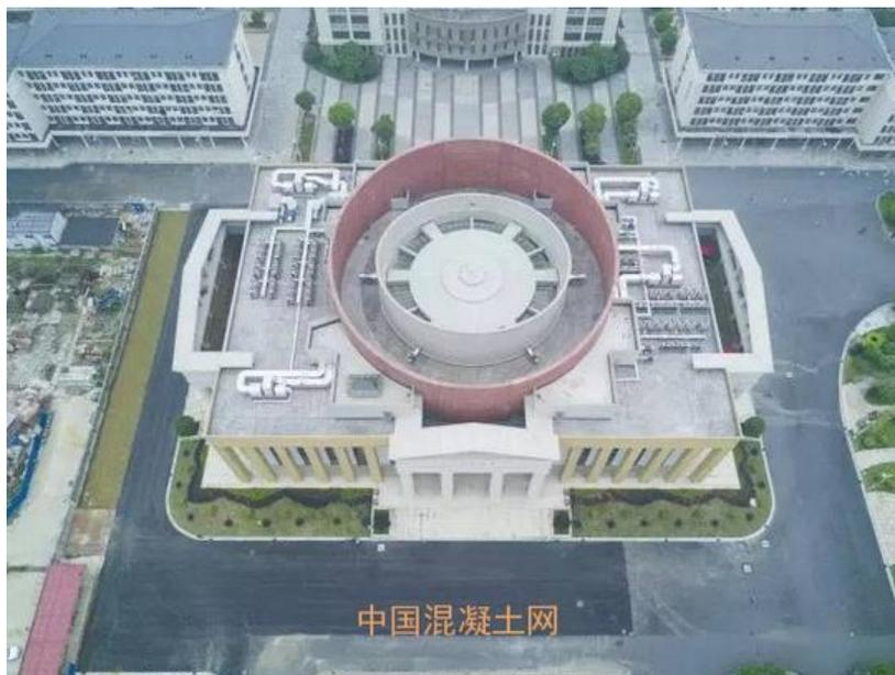
越秀外国语学院图书馆工程位于浙江越秀外国语学院镜湖校区内，为框架剪力墙结构，地下一层，地上四层，总建筑面积 18916 平方米，总占地面积 4768 平方米，是校园内的标志性建筑。施工过程中，项目团队攻坚克难，创新融入多项施工工艺，运用超大体量本色与彩色清水混凝土完美诠释了设计理念，铸就了国内首个大体量彩色清水混凝土建筑的丰碑。
